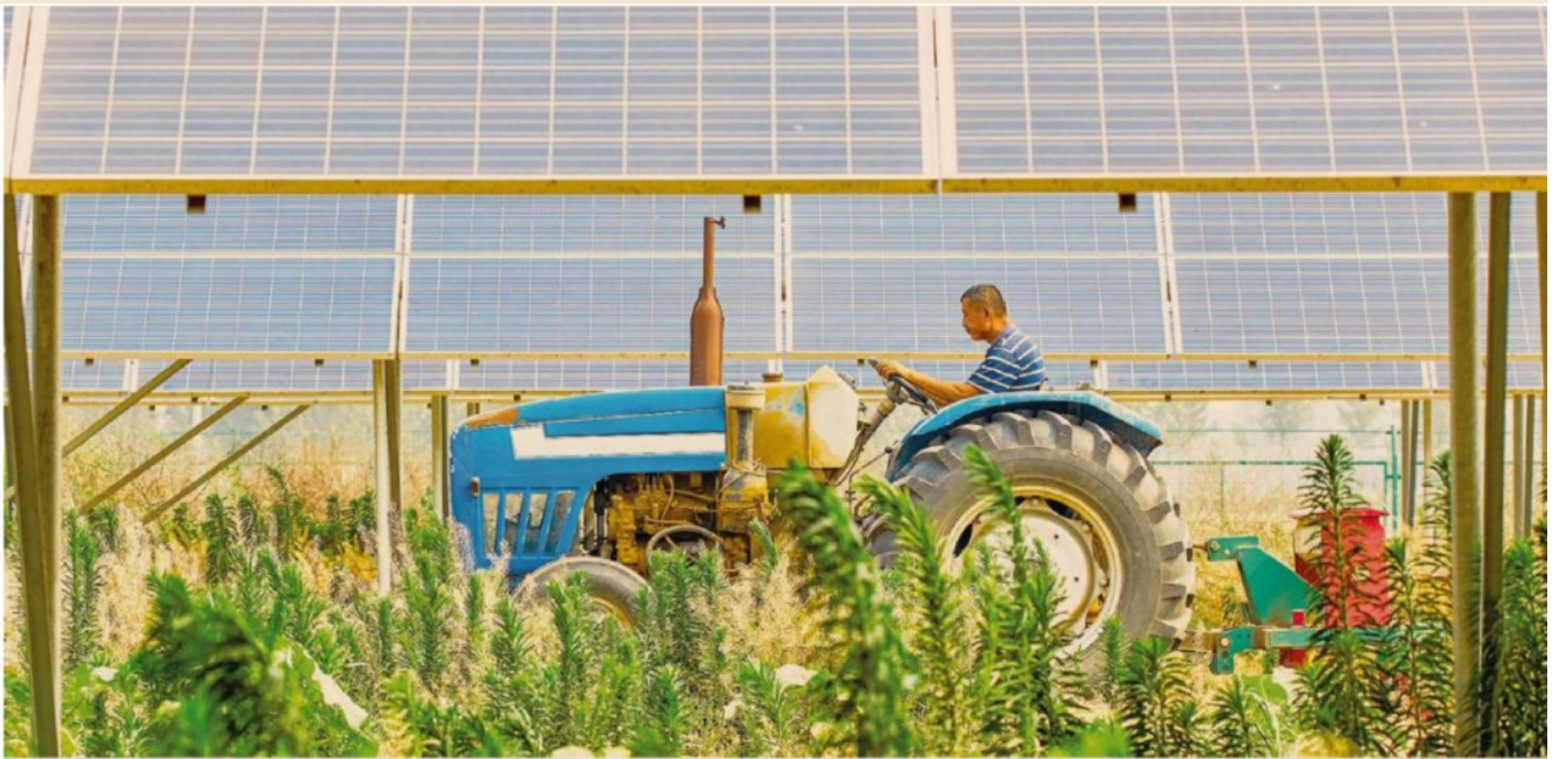
Sinergia vincente. Gli impianti agrivoltaici sono strutture che combinano la produzione di energia solare fotovoltaica con l'agricoltura tradizionale. Le piante coltivate possono essere sistemate sotto o intorno ai pannelli solari, sfruttando al massimo lo spazio disponibile. Questo approccio consente di utilizzare il terreno per scopi agricoli senza compromettere la produzione energetica e viceversa
